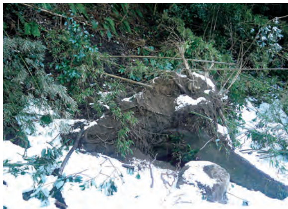
墓地斜面の崩落
