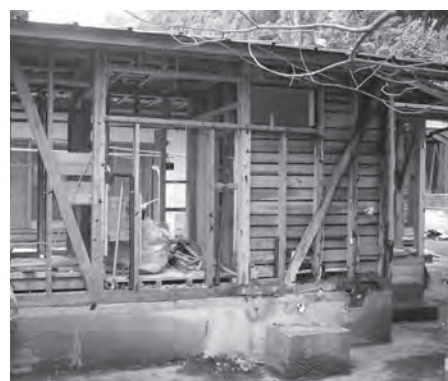
解体中の旧住居
