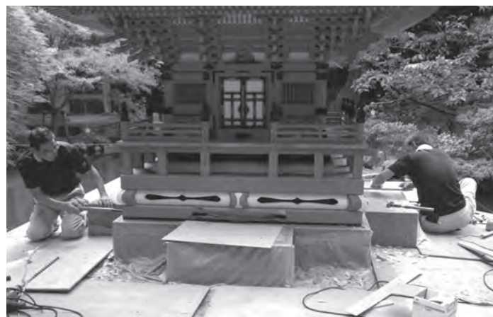
工事中の様子
