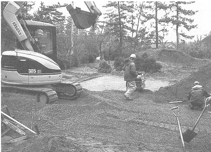
木の移植と道路付け替え工事が進行中
