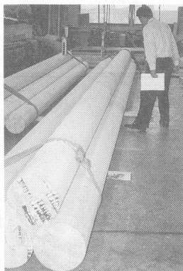
本堂内部の丸柱の検査
